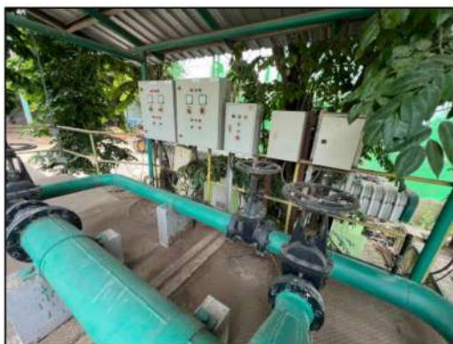
รูปที่ 17 ระบบบำบัดน้ำเสียโรงไฟฟ้า
