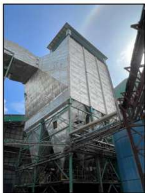
รูปที่ 1 ระบบดักฝุ่นแบบไฟฟ้าสถิต (ESP)
